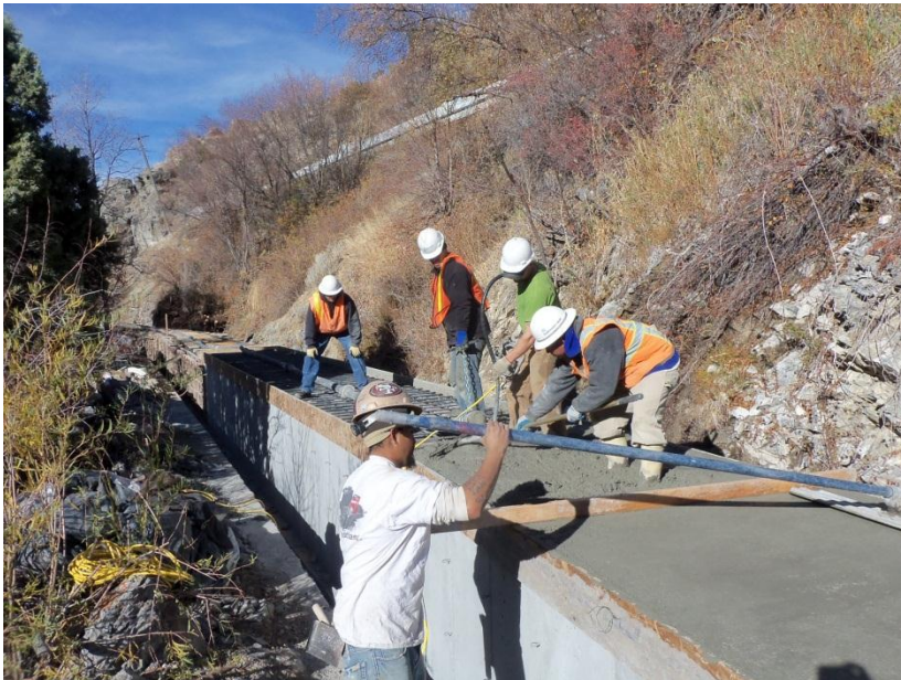
Roof Pour in Canyon Segment
